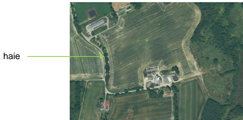
Figure 1 : Vue aérienne du projet
